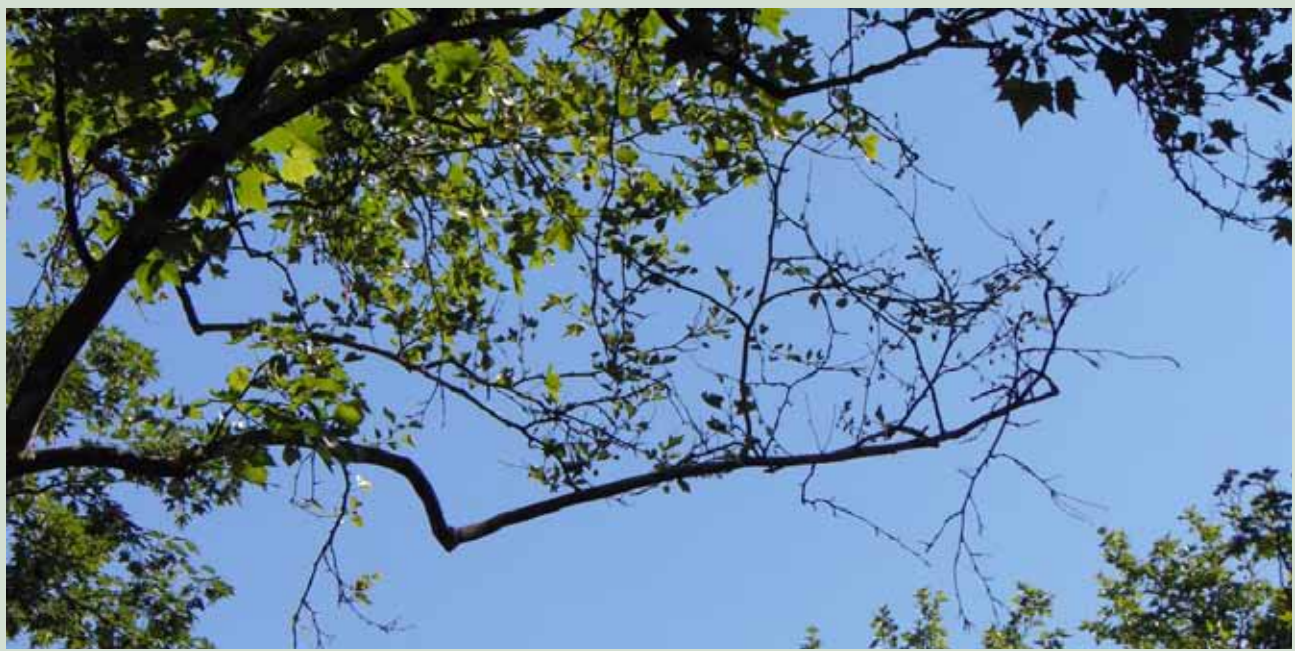
Fot. 2. Usychające konary platana zainfekowane przez Massarię mogą stanowić zagrożenie dla ruchu ulicznego
