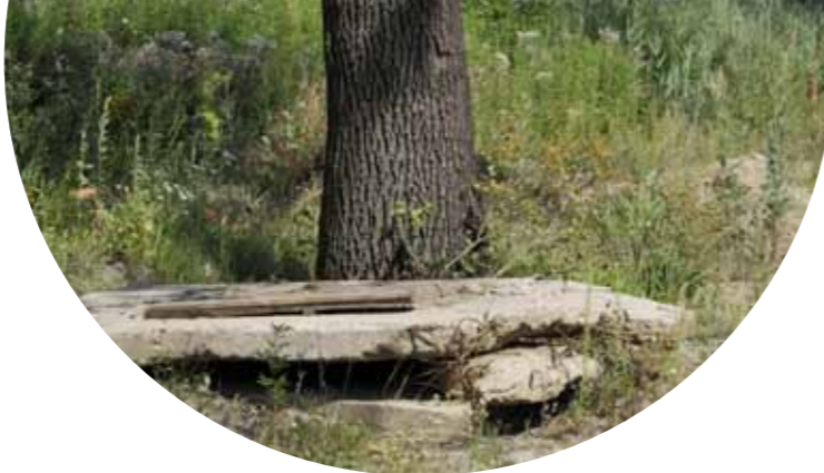
Składowanie betonowych płyt pod drzewami nie jest dobrym pomysłem...
